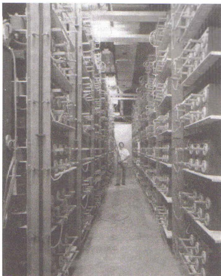
**FIGURA 30-10.** Este banco de 10,000 capacitores en el Lawrence Livermore National Laboratory almacena 60 MJ de energía eléctrica y la libera en 1 ms a lámparas de destello que activan un sistema de láseres. La instalación forma parte del proyecto Nova, que intenta producir reacciones sostenidas de fusión nuclear.
