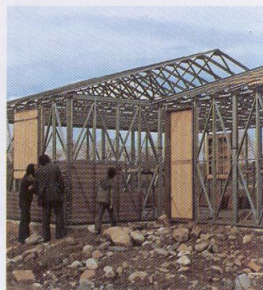
Ventanas y puertas prefabricadas sobre estructura metálica
